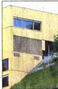
Öko-Bau St. Gerold. (Foto: amp)
